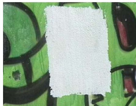
3. Aufgeweichte Schutzschicht inklusive Graffiti unter leichtem Druck abspülen
