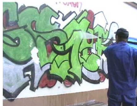
2. Fläche mit Heißwasser-Hochdruckreiniger erwärmen (ca. 90 °)
