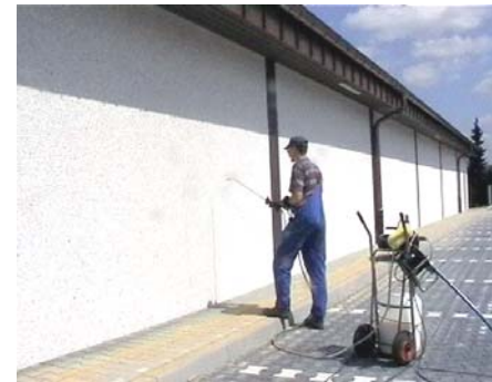
1. AGS 3502 / 3512 im Kreuzgang in 2 Schichten aufsprühen
