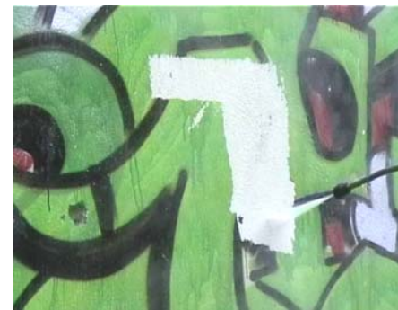
3. Aufgeweichte Schutzschicht inklusive Graffiti unter leichtem Druck abspülen
