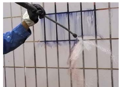
3. Die Graffittischatten einfach mit Heißwasser-Hochdruckreiniger abwaschen
