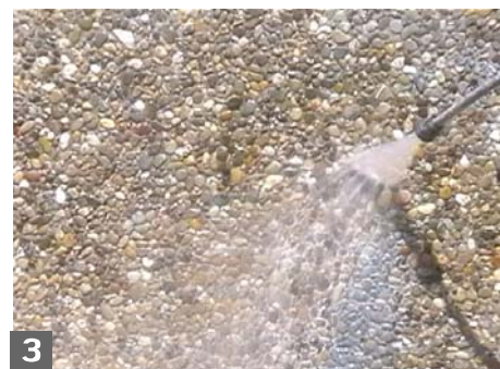
3 Darauf achten, dass die gesamte Chemie aus der Oberfläche gewaschen wird
