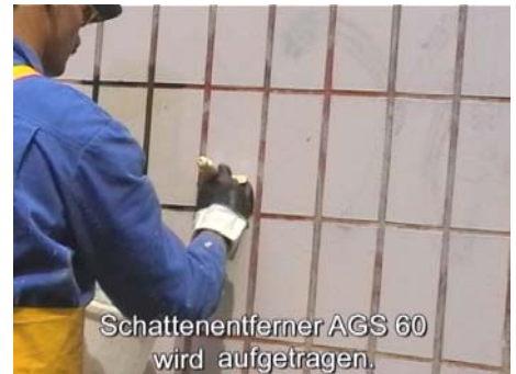
1. TENSID AGS 60 einfach mit dem Pinsel oder Handsprühgerät auftragen
