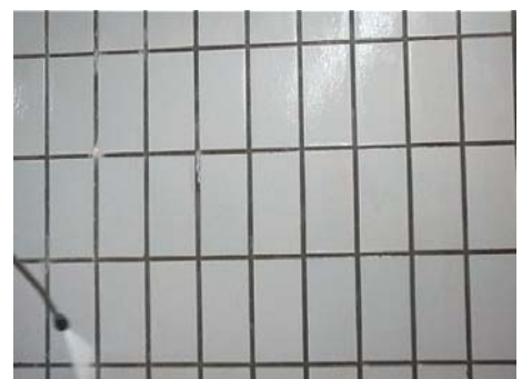
4. Abschliessend mit TENSID AGS 3502 schützen
