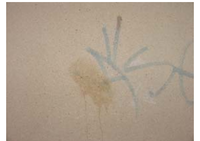
2. TENSID E 250 aufsprühen und warten
